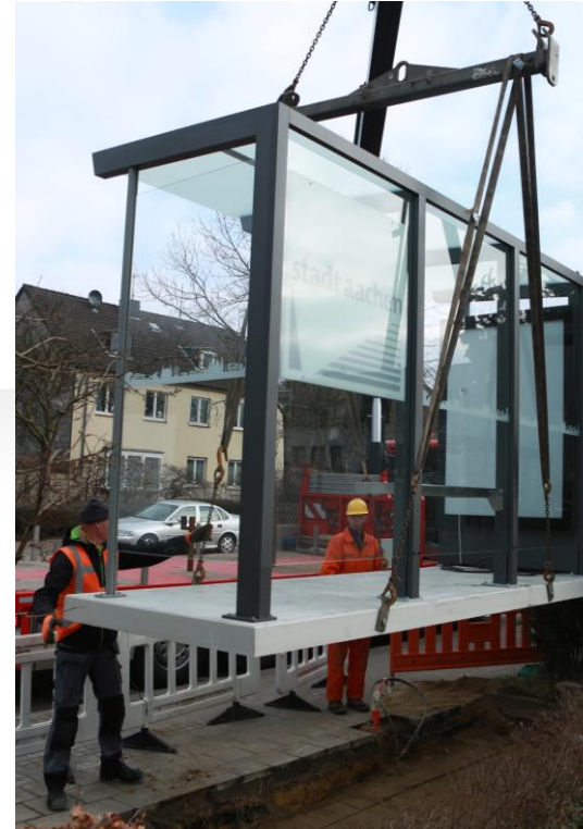
Platzieren mittels Kran-LKW
