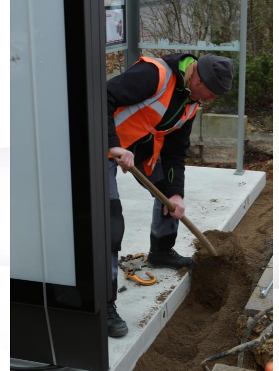
Deckenschluss – Überpflastern
