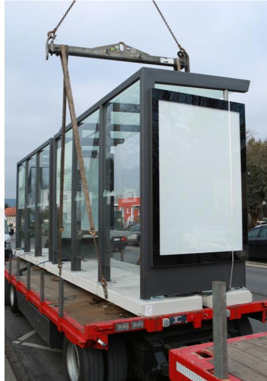
Anlieferung mit Kran-LKW
