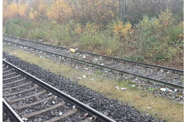
Verunreinigtes Gleisbett in Quadrath-Ichendorf
