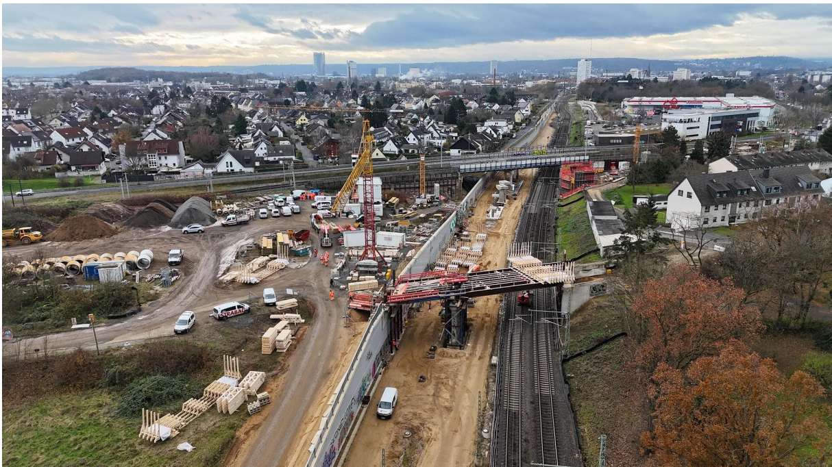
Ausbauarbeiten für die S 13, hier: neuer Haltepunkt Vilich und Schultheißstraße (© Vössing, Frank Klein)
